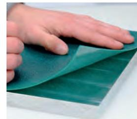
...verlegen Sie secuGrip-90 auf dem Untergrund und drücken Sie das Laminat gut an.
