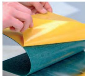
...reinigen Sie den Untergrund auf dem Sie das Laminat verlegen möchten und ziehen Sie die Folie ab ...
